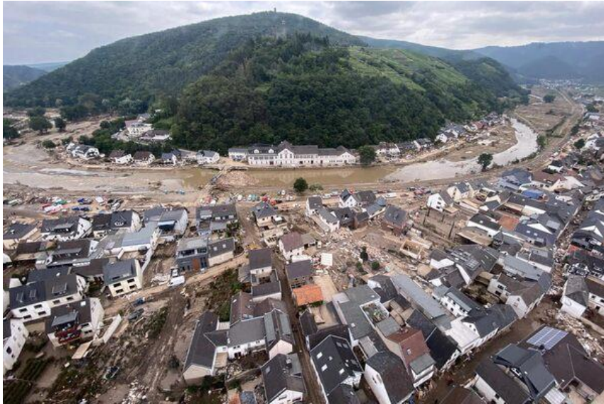
Fehlender Retentionsraum in urbanen Gebieten
