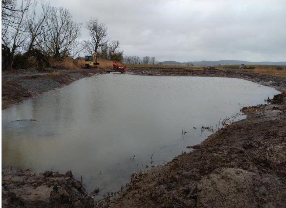
Abbildung 18 a-c: Anlage eines Denitrifikationsbeckens und Feuchtflächen (boden:ständig-Projekt Haubach) © GeoTeam (2023)
